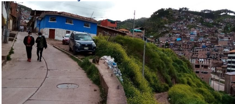
Imagen N° 82: Estado actual de la AV-02
