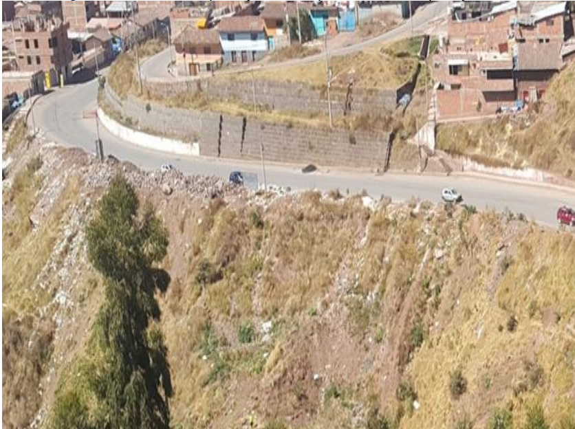
Imagen N° 103: Quebrada Sipasmayo alteradas por residuos municipales y escombros
