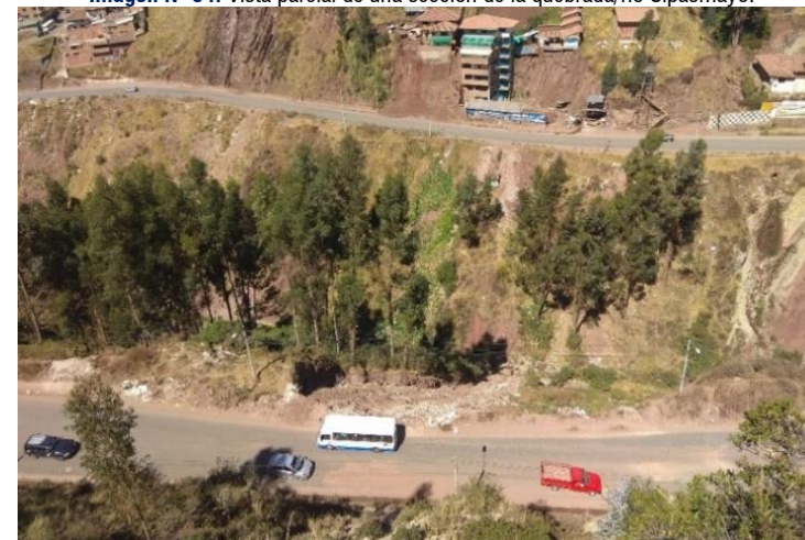
Imagen N° 34: Vista parcial de una sección de la quebrada/río Sipasmayo.
