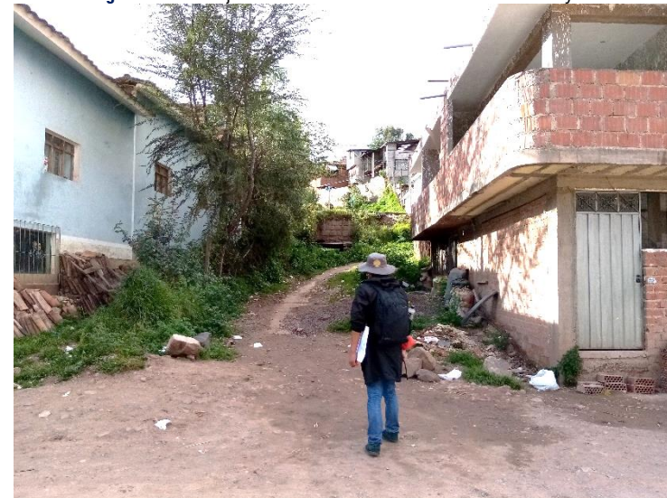
Imagen N° 60: Pasaje Julio c. Tello en estado de conservación muy malo
